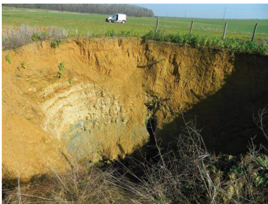
FIGURE 92 EFFONDREMENT DE CAVITE A COURCELLES-SUR-BLAISE SOURCE BRGM ET DDT 52
